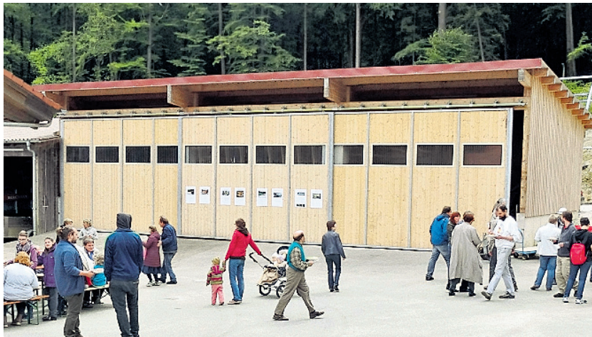
In den vergangenen sechs Jahren wurde auch eine Holzsägehalle gebaut.
